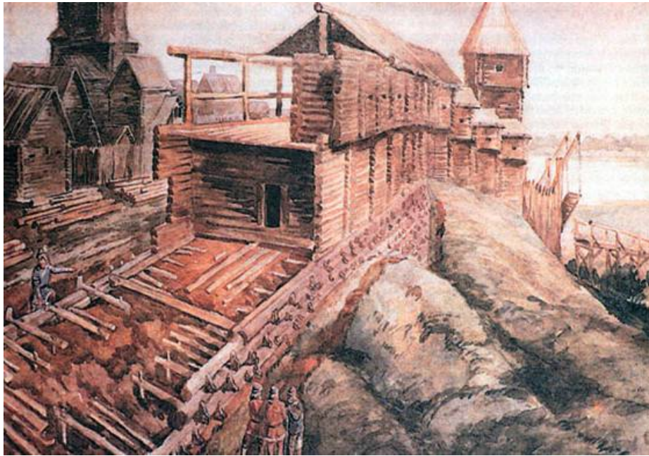
Строительство деревянного Кремля
