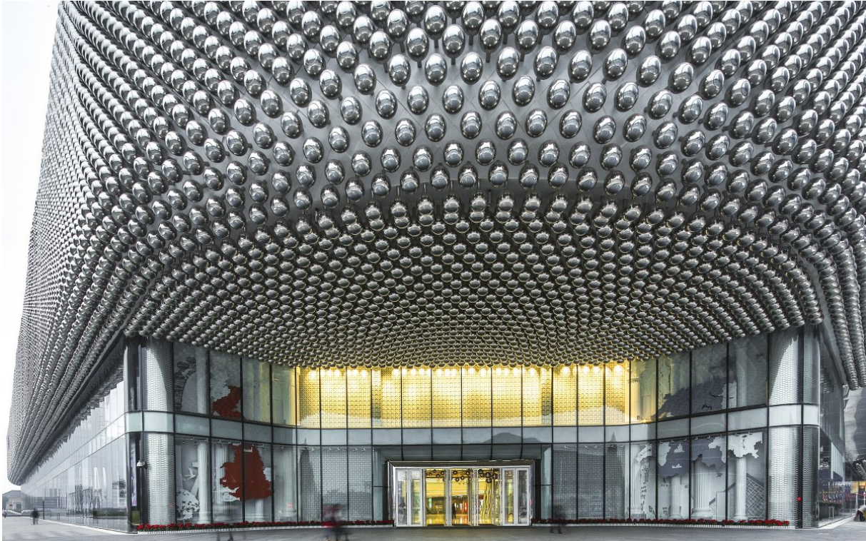
Рис. 16. Фрагмент фасада Торговый центр Nanjie, Ухань (Китай)
