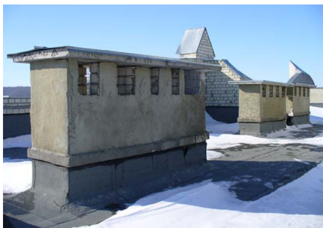
Рис. 7.3. Оголовки вентшахт на ул. Онежской, 21а
