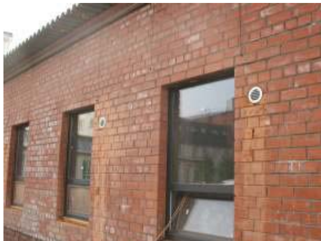
Рис. 7.7. Места установки стеновых клапанов
