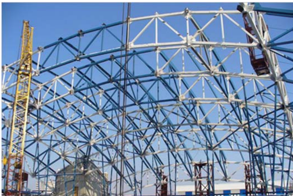
Рис.17. Пример гнуто сварного металлического покрытия
