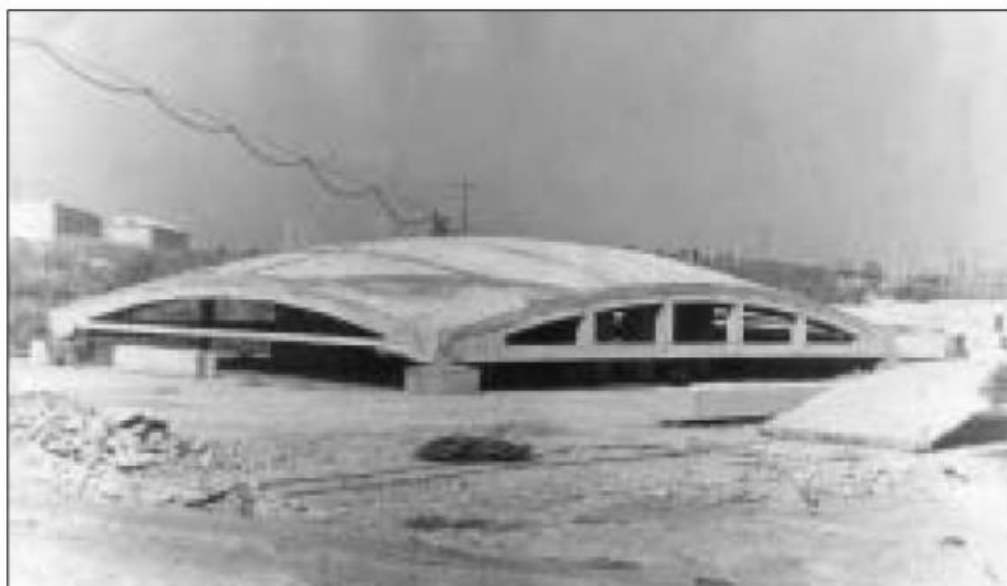
Рис.37. Железобетонная оболочка двойной положительной кривизны
