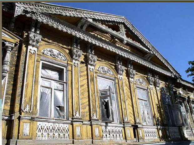
Дом по ул. Володарского, 9 > до реконструкции
