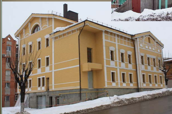
< Дом по ул. Володарского, 11 после реставрации
