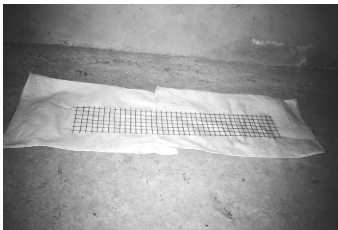
Рис. 4.2. Сварная сетка С-1
