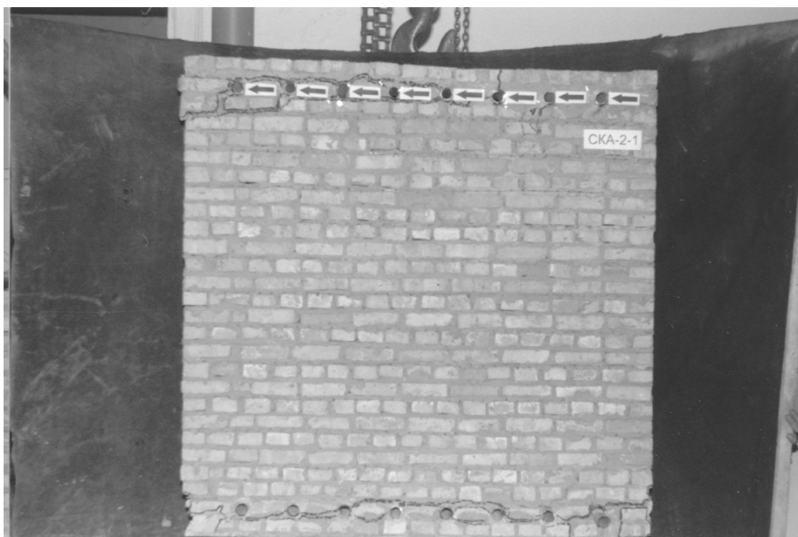
Рис. 6.5. Характер образования трещин. Вид разрушения образца стены СКА-2-1
