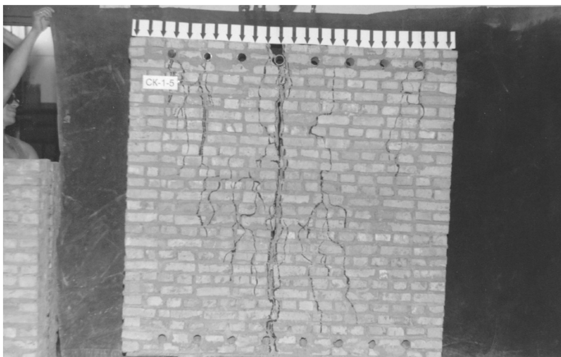
Рис. 6.3. Характер образования трещин. Вид разрушения образца стены СК-1-5
