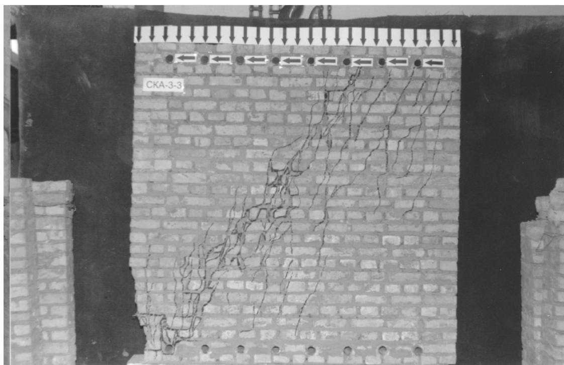
Рис. 6.12. Характер образования трещин. Вид разрушения образца стены СКА-3-3
