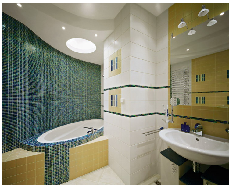
Рис. 70. Ванная комната с облицовкой стен керамической плиткой и мозаикой
